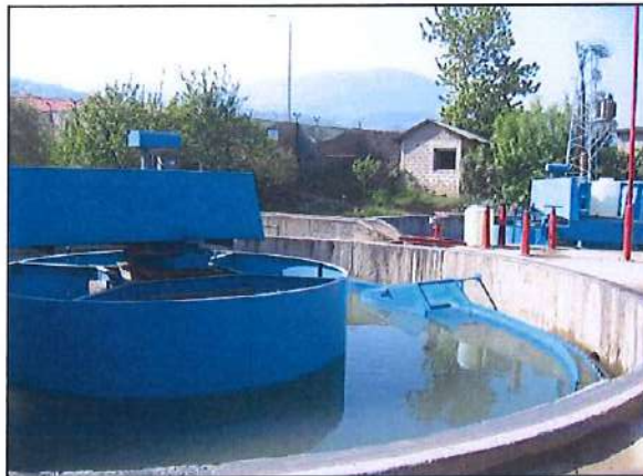
Figura 7: Koagulimi, fabrika për përpunimin e ujit të pijshëm
